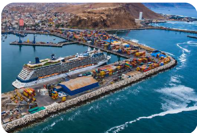
Fotografía: Terminal de Puerto Arica de Portal TPA
