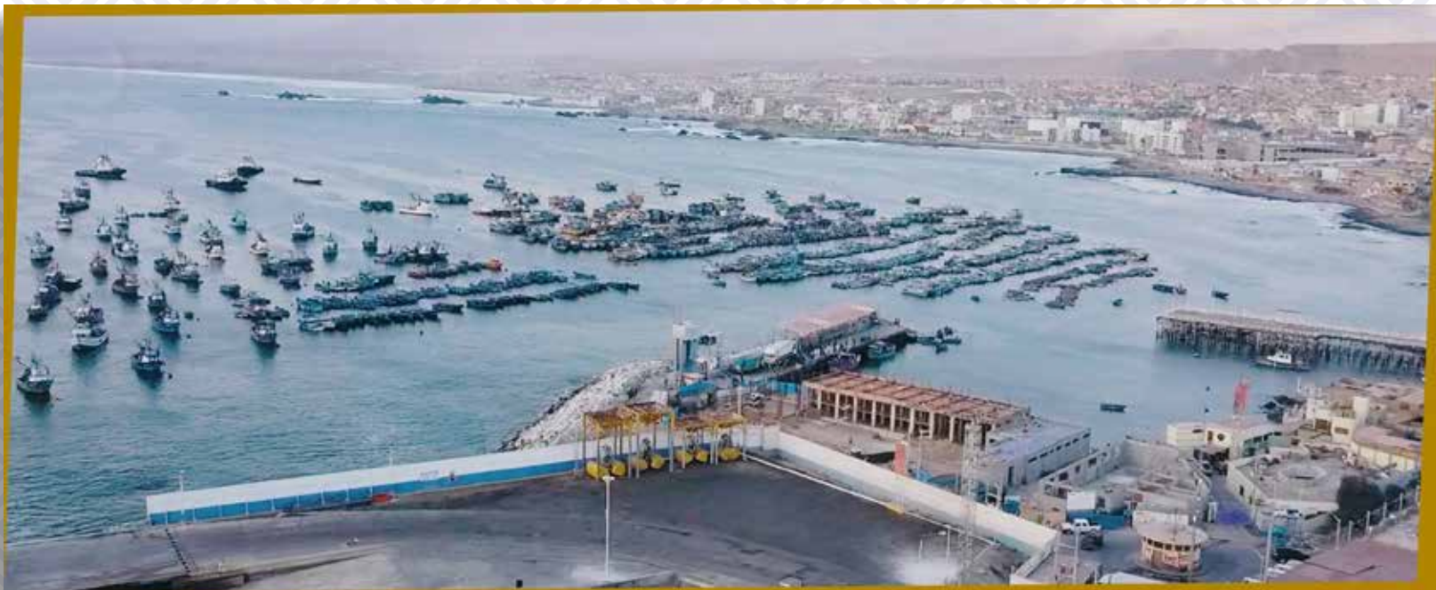
Fotografía: Vista general panorámica del Puerto de Ilo
